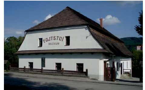
budova Fajtství z cesty pod Bílou horou
