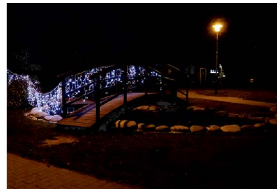
mostek ve Staré Bělé
